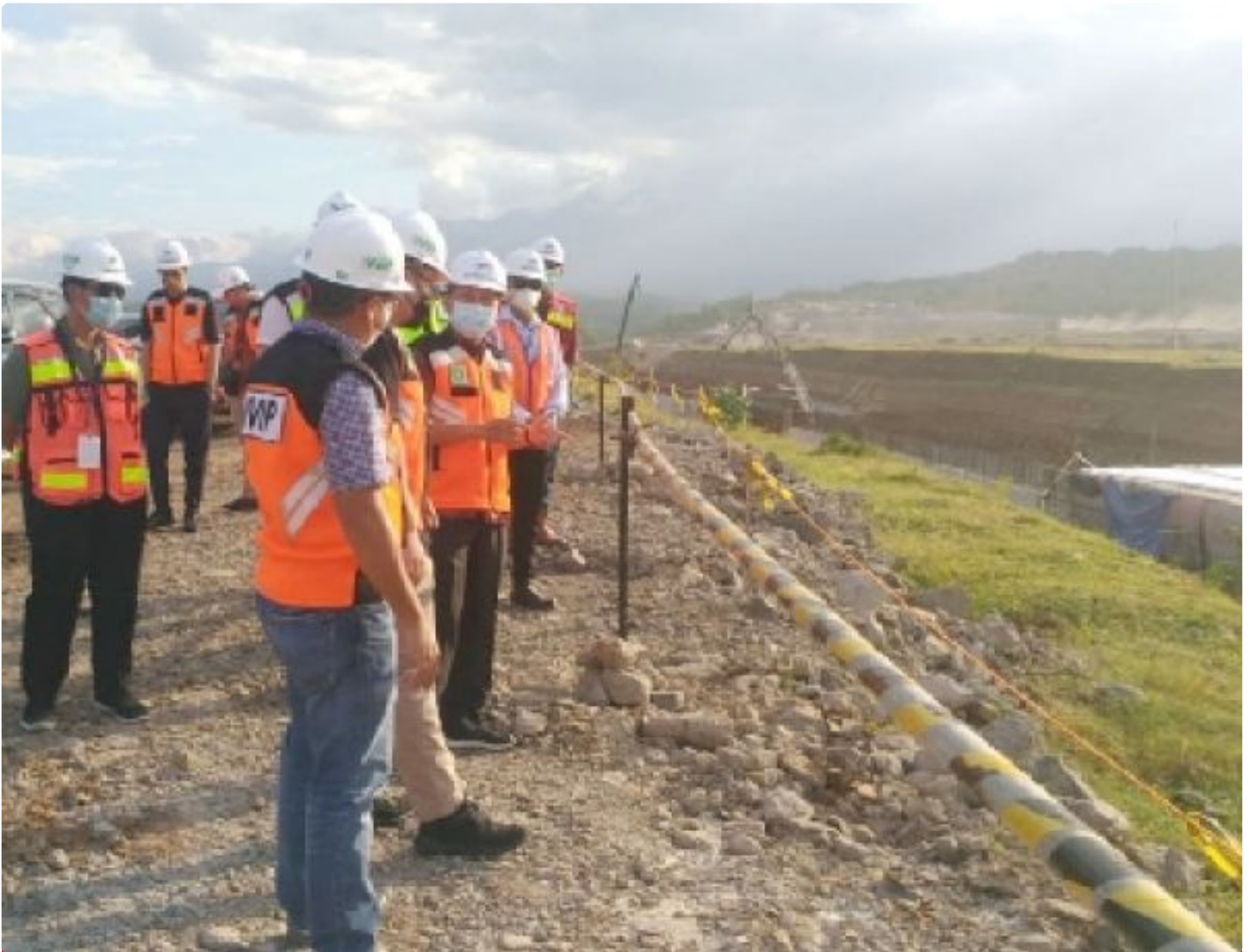
Mas Dhito melihat langsung progress pembangunan Bandara Kediri
